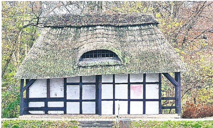
Die sanierungsbedürftige Fischerhütte Anfang Januar und saniert im November 2022
